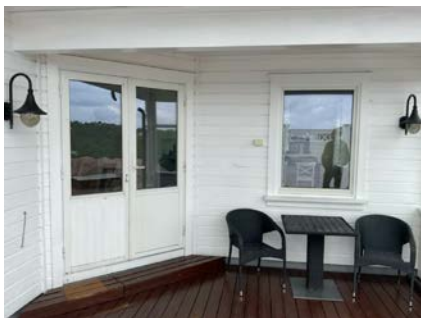
To fløy balkongdør ut fra stue.
