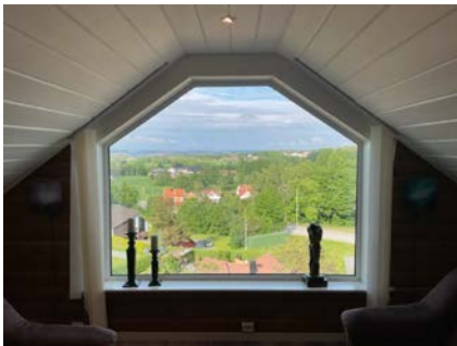
Pvc vindu på loft.
