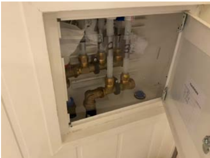
Vannskap bad loft.
