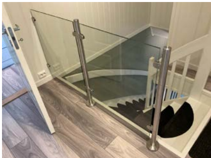
Glassrekkverk i toppen av trappen.
