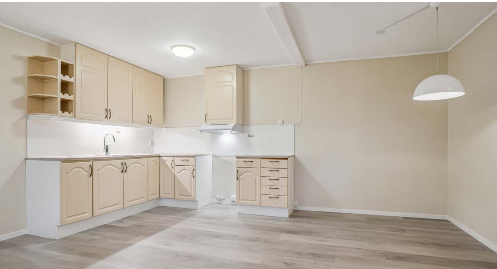
Kjøkkeninnredningen er oppgradert i 2022 med melaminbelagte skrog og malte profilfreste dører og fronter. Tidligere bod er lagt til kjøkkenet.
