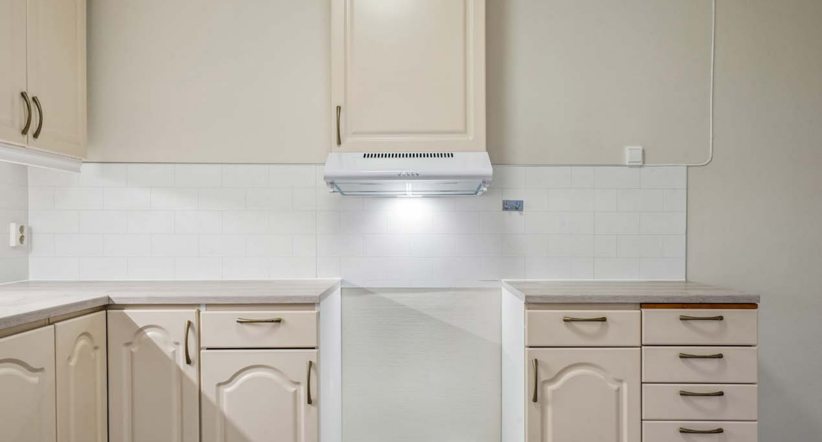
Kjøkkeninnredningen har laminat benkeplate, kitchen wall mellom benk og overskap, opplegg for komfyr og ventilator.
