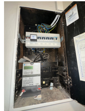
Sikringskap med automatsikringer.
