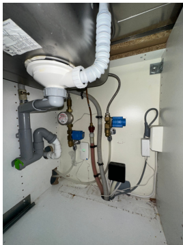
Rørpropp i kjøkkenbenk med Waterguard
