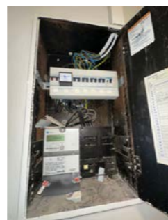
Sikringsskap med automatsikringer.
