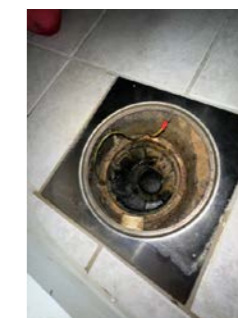
Plastsluk med klemring for membran
