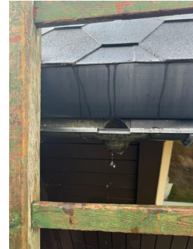
Nedløpsrør blir koblet til før salg
