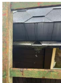
Nedløpsrør blir koblet til før salg
