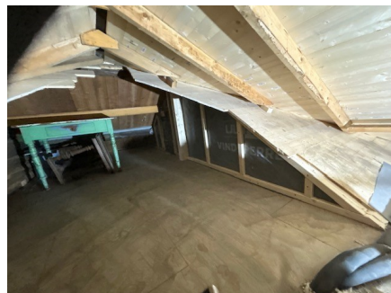
Vegg mot stue er utbedret etter befaringen med vindsperre og lekter.
