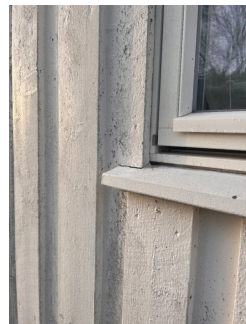
Omramming helt ned på vannbrett
