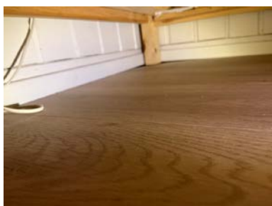
Svikt underlag laminat, stor glippe under gulvlist.
