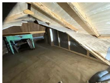
Vegg mot stue er utbedret etter befaringen med vindsperre og leker.
