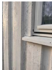
Omramming helt ned på vannbrett
