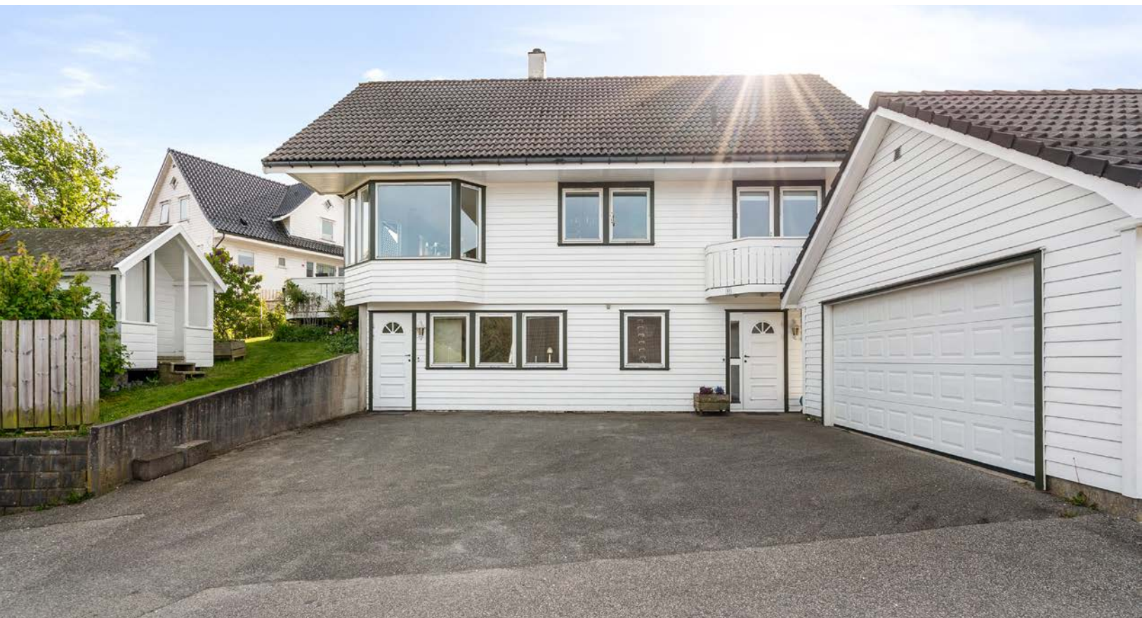
Det er installert elbil-lader i garasje.
