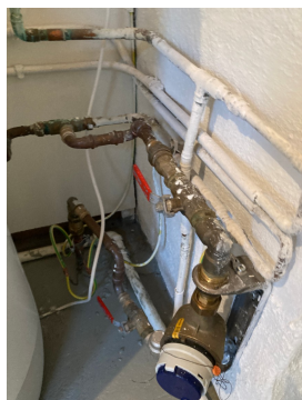
Vannmåler/stoppekrane i bod, til hoveddel
