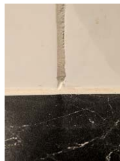
Rørgjennomføring for stort, hull i flis er tettet med silikon
