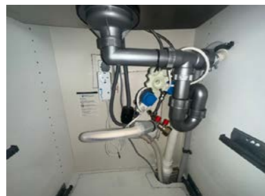
Rørlegg i kjøkkenbenk med Waterguard
