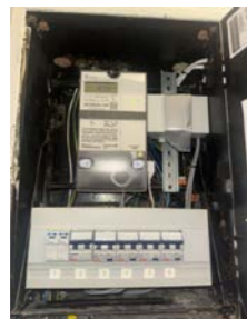
Sikringskap med automatsikringer.
