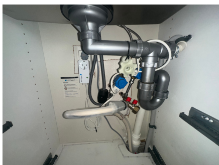
Røropplegg i kjøkkenbenk med Waterguard
