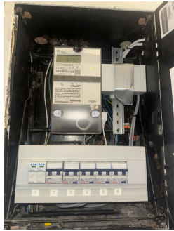
Sikringskap med automatsikringer.
