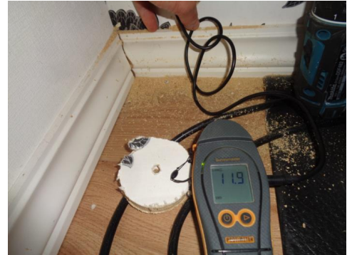
Ingen unormale fuktverdier registrert.
