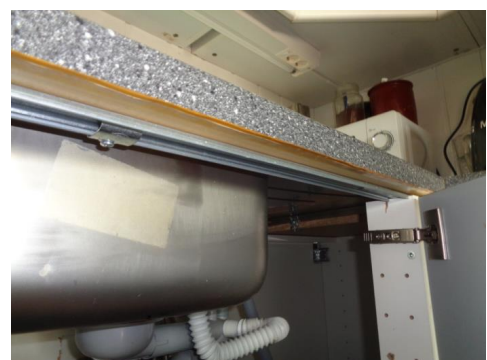
Slitt underside av benkeplater.
