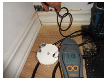
Ingen unormale fuktverdier registrert.
