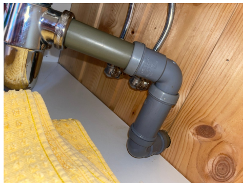
Rørgjennomføring mangler tettesjikt.
