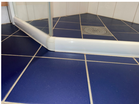
Tett list ned mot gulv som hindrer evt. lekkasjevann til sluk.
