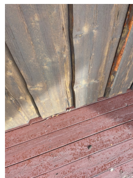
Værslitt/oppsprukket ytterkledning.
