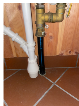
Ufaglig tettesjikt rundt rørgjennomføringer.
