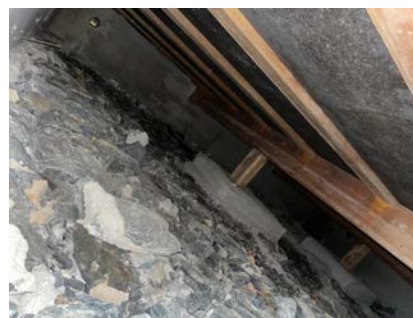
Muggsopp på overflater til stubbelofter
