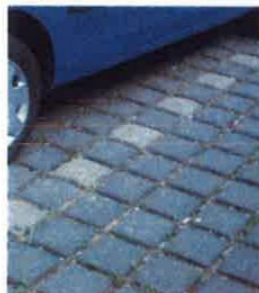
Figur 8: Permeabel belægning opnået med ekstra brede fuger. Foto: A. Backhaus.
