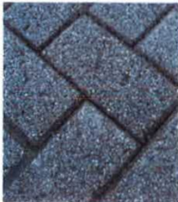
Figur 7: Permeabel belægning opnået med porøse betonsten. Foto: M.B. Jensen.
