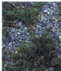
Figur 5: Permeabel belægning opnået med grøsarmeringssten. Foto fra www.eastcoastgreen.info .
