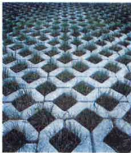
Figur 5: Permeabel belægning opnået med grøsarmeringssten. Foto fra www.eastcoastgreen.info .
