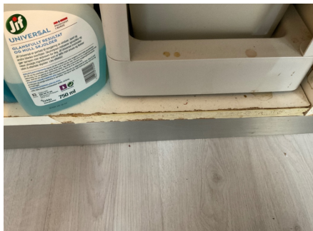
Svelling i bunnplate på benkeskap.
