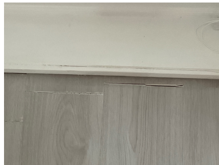
Gliper i laminatgulv.
