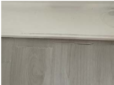
Gliper i laminatgulv.
