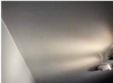
Ujevne sparklede overflater
