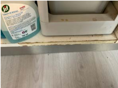
Svelling i bunnplate på benkeskap.
