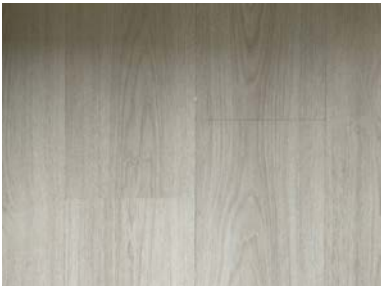
For kort omlegg mellom skjøter
