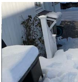
Terrasse: Ikke rekkverk fra trapp mot vegg.
