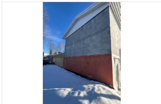
Fasade på nedsiden mot naboen.
