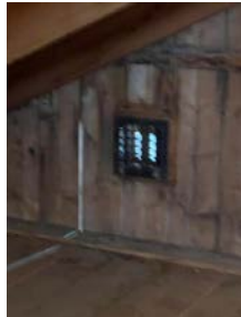
Veggventil for lufting i gavlvegg.
