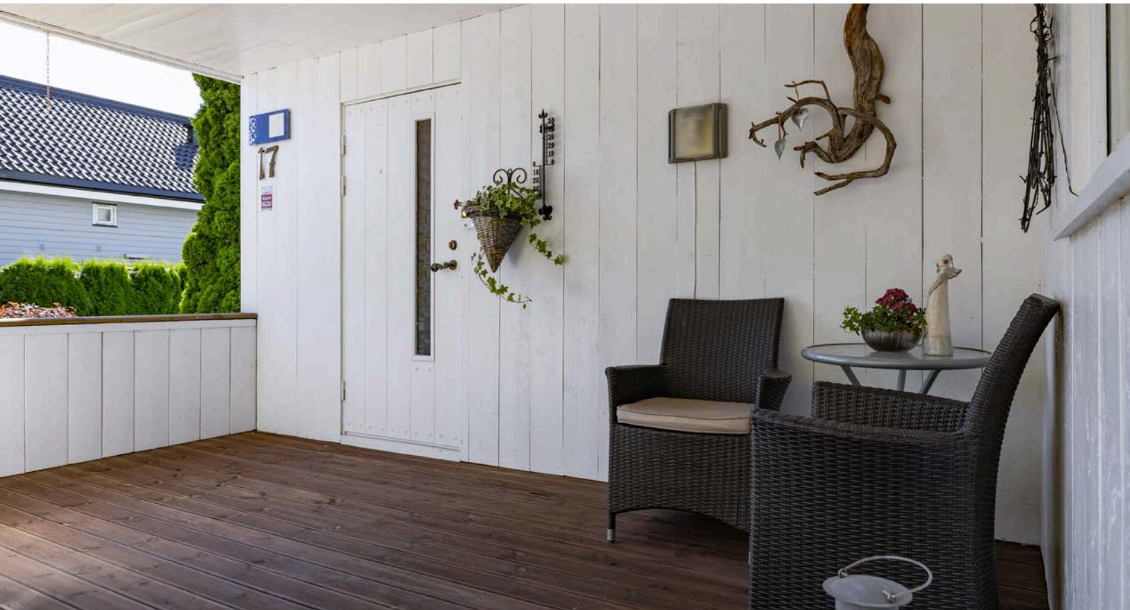
Boligen har to innganger og dette er ved hovedinngangen som har et romslig, overbygd inngangsparti på ca. 9 m 2 .
