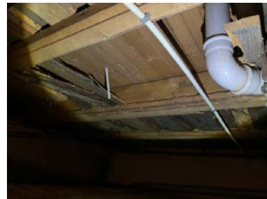
Kjeller: Uisolerte felt i etasjeskiller.
