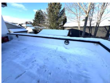
Forstøtningsmur ved garasje/parkering.
