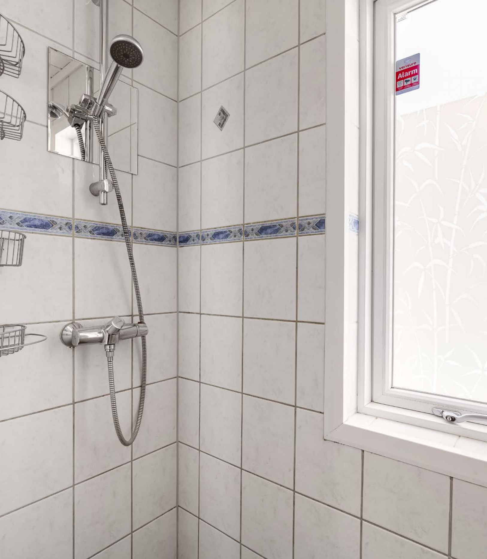
Dusjnise med dusjdører og veggmonert dusjbatteri.
