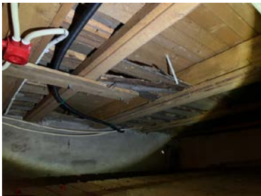
Kjeller: Uisolerte felt i etasjeskiller.
