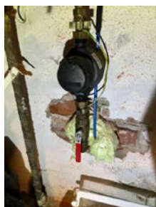
Vanninntak/stoppekran i kjeller.
