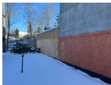
Forstøtningsmur ved garasje/parkering. Fra nedsiden.
