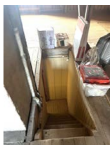
Terrasse: Ikke rekkverk fra trapp mot vegg.
