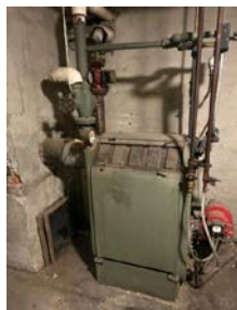
Sentralfyrlegg som ikke er i bruk.
