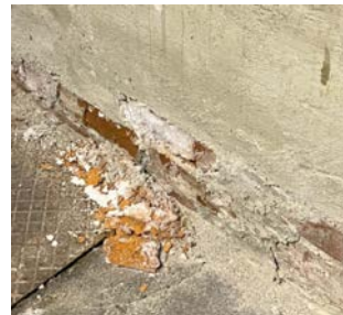
Grunnmur på sørsiden: Ingen synlig utvendig tettesjikt.
