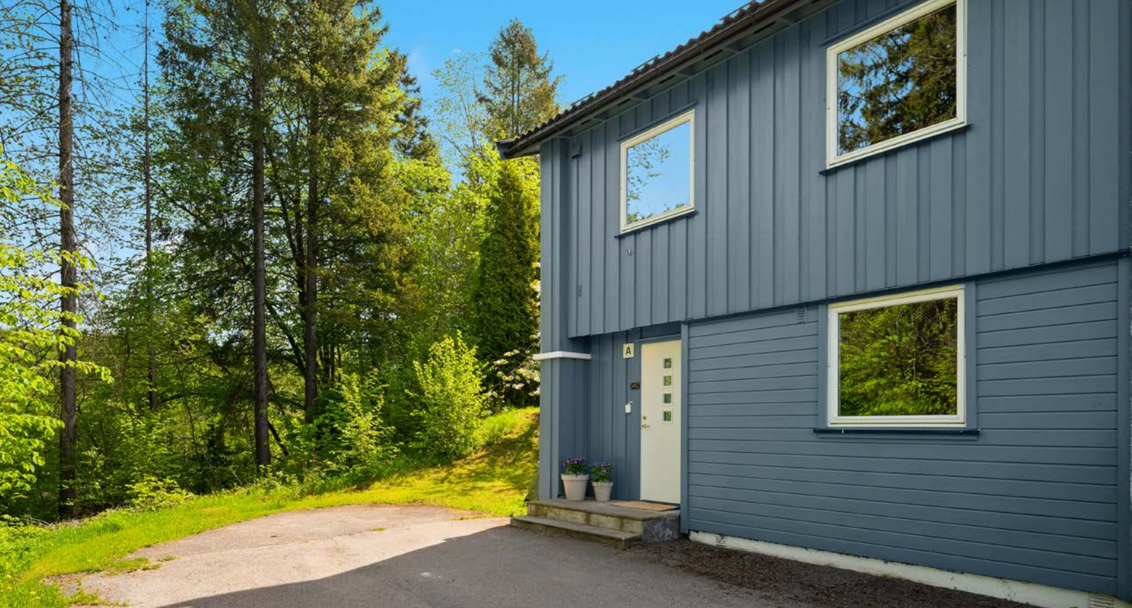
Inngangsparti med mulighet for biloppstilling. Det er montert elbillader på endeveggen
