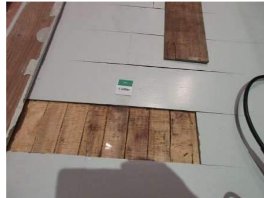
Foto 38. Muggvekst påvist i prøve av undersiden av parkettlamell. Parketten hadde sprukket opp.
