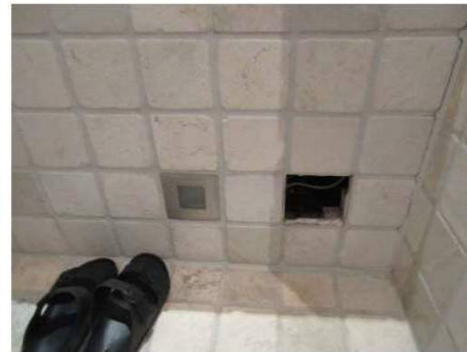
Foto 32. Det var tatt ut en lufterist på hver side av fronten til boblebadet for innkikk på undersiden.
