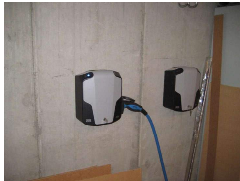
Avvik 38: Ladeenheter har ikke godkjent forankoblet vern.
