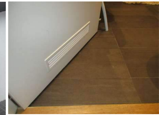
Foto 6. Lufteventil nylig montert i dørene for bedret luftsirkulasjon mellom rommene.
