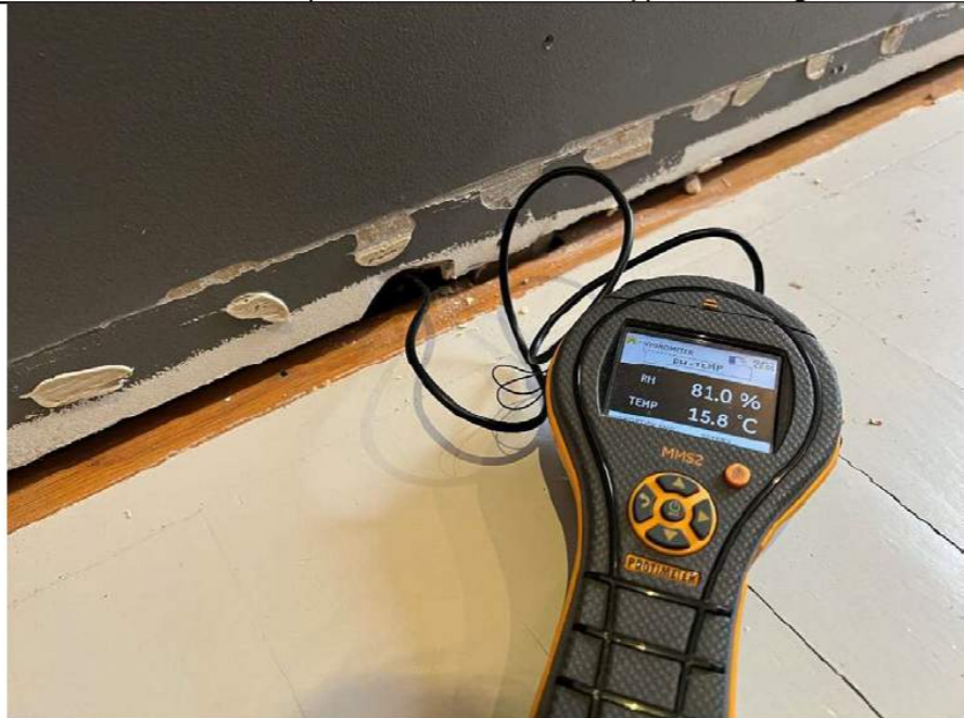
6. Bildet viser måling av fukt i hulrommet under gulvet.
