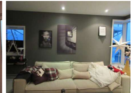
Foto 36. TV-stue. Det har vært lekkasje fra taket i september 2022 ved vegg bak sofa.
