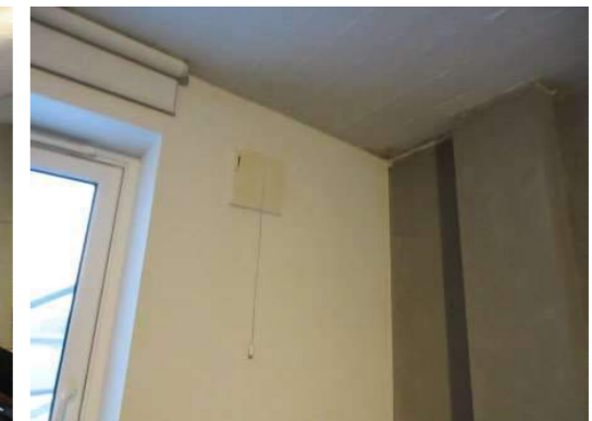
Foto 24. Lufteluke i yttervegg.
