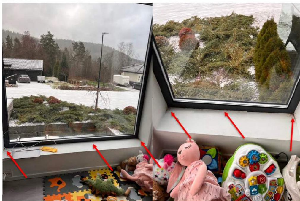
Piler på bildene over viser sopp i vinduskarmer. Disse vinduene er i stuen til utleieleiligheten. Slike vinduer er også montert i hovedboligen. Vinduene har for smal karm (dårlig isolering) og er ikke tilstrekkelig isolert og tett rundt.
