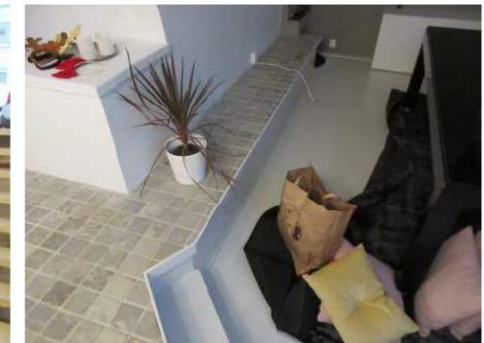
Foto 30. Det er nivåforskjeller på gulvet. Øvre del er flislagt. Nedre del antas å være et oppført malt platégulv.
