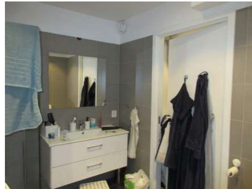
Foto 7. Bad med avtrekk i øvre del av vegg mot teknisk rom/ bod.
