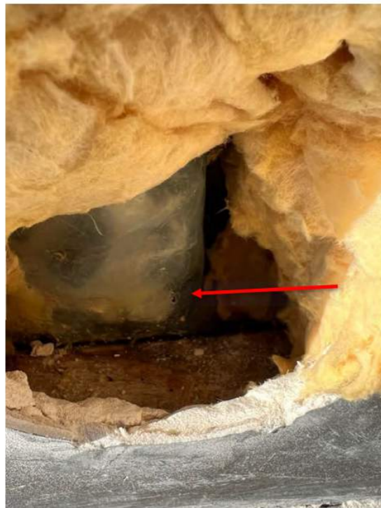
Pil på bildet viser undertegnades hånd som ble fuktig da jeg stakk hånden inn i hullet hvor det er avdekket vannskader i konstruksjonen. I denne veggen er det et nedløpsrør til taksluk. Det er mye vann i veggen og isolasjonen er gjennomvåt.
