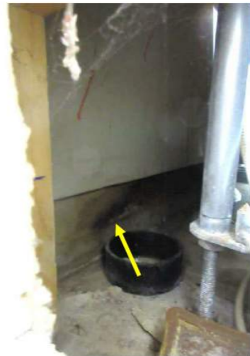
Foto 33. Underside av kar, sett fra venstre åpning. Begrenset synsfelt og svak kvalitet på foto. Veggplate under karet kan skimtes. Prøve tatt i området markert med pil.
