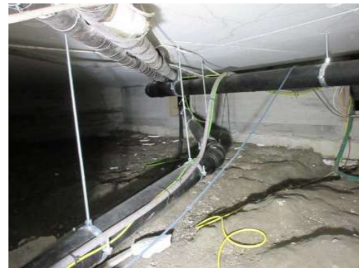
Foto 51. Krypekjeller. Rørføringer og kabler.
