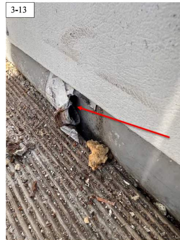
Pil på bildet viser at membranen på taket over inngangen, under terrassekonstruksjonen, er teipet og ikke sveiset. Alle typer takmembraner SKAL sveises/smeltes sammen for å få en fullverdig og tett skjøt. Det er altså ikke akseptabelt å teipe skjøter på denne måten da teip smuldrer opp og slipper innen kort tid. Det er gode grunner til å mistenke at membranen også er teipet i hele skjøtens lengde under terrassekonstruksjonen. Dette punktet er vurdert mot produsentens anvisning for utførelse og montering av protanmembran.
