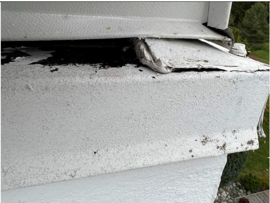
11. Bildet viser at det er lagt beslag med fall over det gamle beslaget. Valgt løsning er ikke tett, og det er brukt fugemasse for å sikre tetthet. Ikke fagmessig utførelse.
