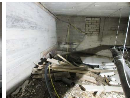
Foto 49. Krypekjeller. Noen rom har mye lagrede bygningsmaterialer. Risiko for muggsopp- og råteskader i dette.
