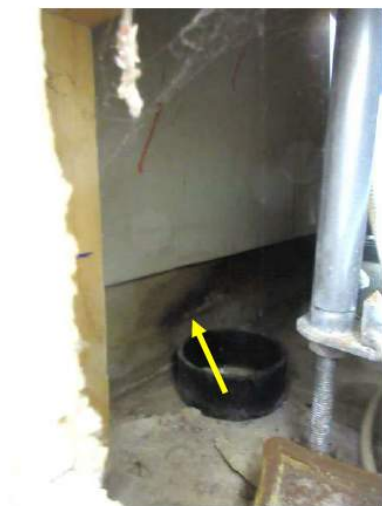
Foto 33. Underside av kar, sett fra venstre åpning. Begrenset synsfelt og svak kvalitet på foto. Veggplate under karet kan skimtes. Prøve tatt i området markert med pil.
