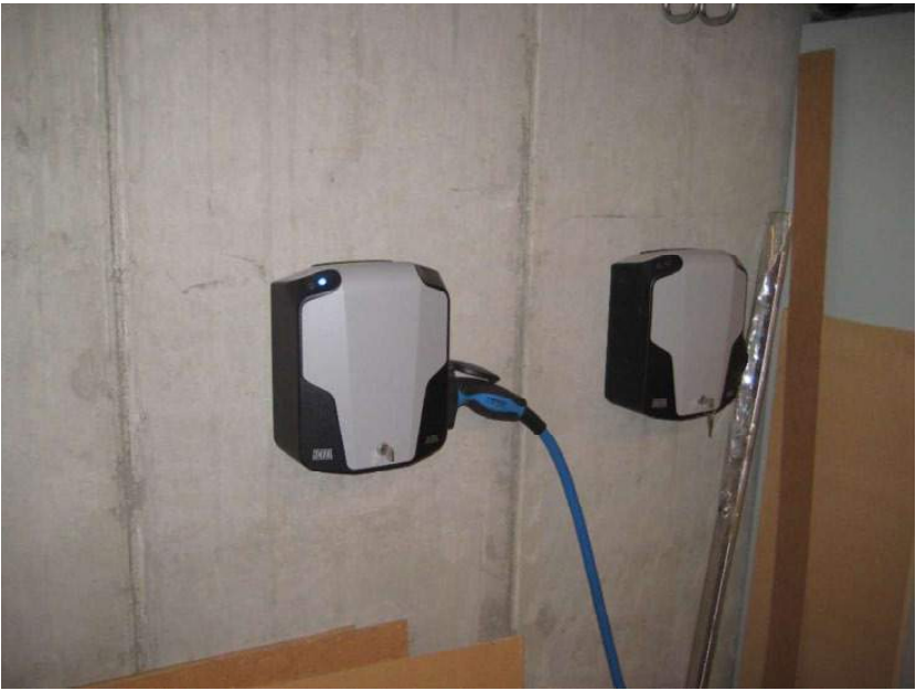
Avvik 38: Ladeenheter har ikke godkjent forankoblet vern.
