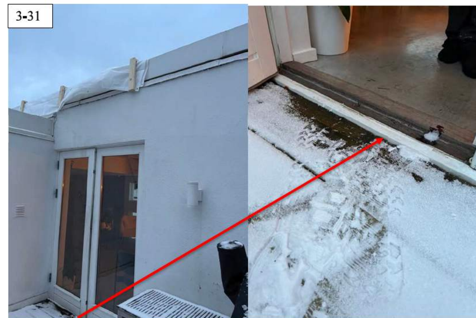
Pil på bildet viser terskelen til balkongdøren til kjøkkenet. Bildet til venstre viser at det ikke er tak over døren og fører dermed til at regn- og smeltevann renner inn i boligen. Å kun etablere rist utenfor døren vil ikke løse problemet da slike rist fylles med is på vinteren samt løv og annet på vår/høst som vil føre til at risten mister sin funksjon. Det er en bransjebefaling med tak over inngang- og balkongdører for å forhindre regn og snø fra å renne mot åpne konstruksjoner som dører.
