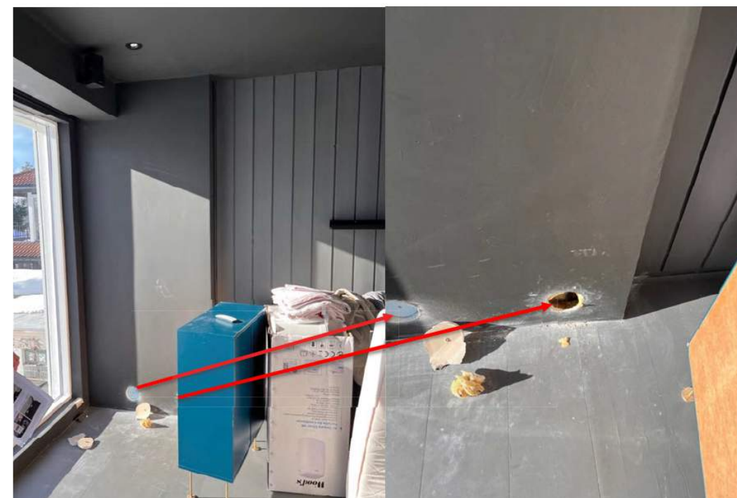
Piler på bilder over viser to hull som er åpnet i vegg i forbindelse med Mycoteam's undersøkelser.
