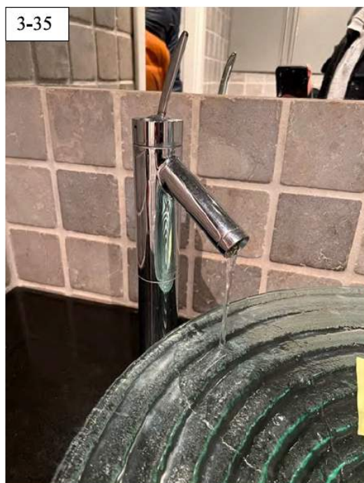
Bildet viser at et av blandebatteriene er defekt. Får ikke ut tilstrekkelig med kaldtvann tilsvarende trykket som vannet er stilt inn på (4 Bar).
