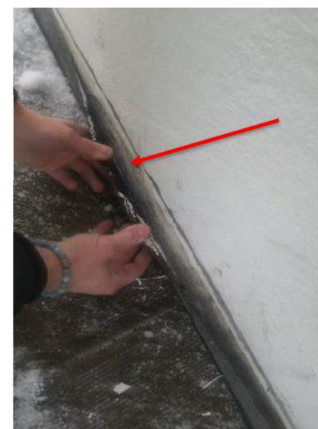
Pil på bildet viser at membranen på taket over inngangen, under terrassekonstruksjonen, er teipet og ikke sveiset. Alle typer takmembraner SKAL sveises/smeltes sammen for å få en fullverdig og tett skjøt. Det er altså ikke akseptabelt å teipe skjøter på denne måten da teip smuldrer opp og slipper innen kort tid. Det er gode grunner til å mistenke at membranen også er teipet i hele skjøtens lengde under terrassekonstruksjonen. Dette punktet er vurdert mot produsentens anvisning for utførelse og montering av protanmembran.
