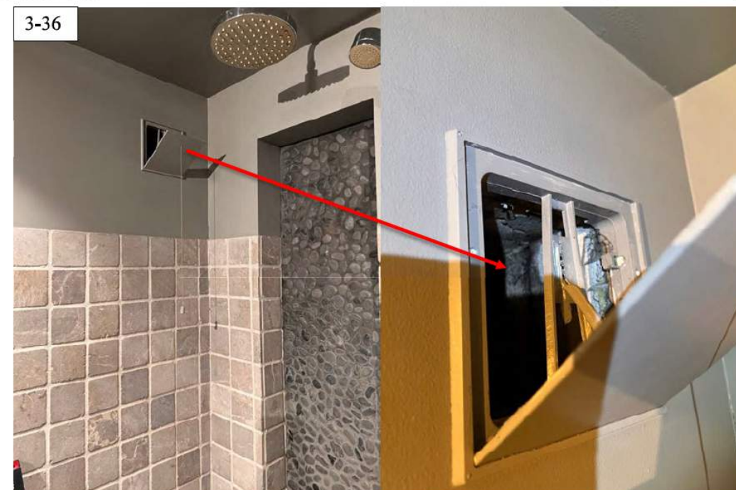
Pil på bilder over viser lufteventil på badet. Ventil mangler kanal og fører dermed til at all damp og kondens trekker inn i konstruksjonen.
