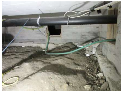
Foto 53. Krypekjeller. Det er flere delrom.
