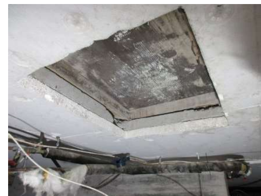
Foto 48. Krypekjeller. Blendet inspeksjonsluke i himling.
