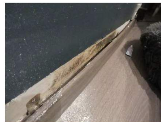
Foto 12. Langvegg under terrengnivå. Muggsoppvekst på gipsplate bak løsnet gulvlist.
