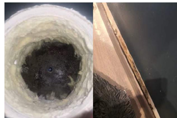
Bildet til venstre viser hullet som er omtalt over, før kjøper laget flere hull i betongen for å undersøke veggtykkelsen. Bildet viser fuktig betongvegg som følge av kondensering. Bildet til høyre viser sopp bak gulvlistene som følge av kondensering av yttervegg og manglende ventilering av rommet.
