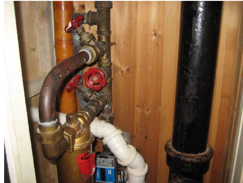
Avvik 23: Manglende utjevningsforbindelser mellom soil, vann og sikringsskap.
