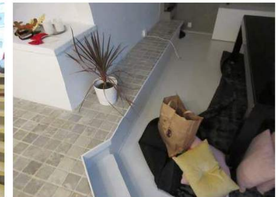
Foto 30. Det er nivåforskjeller på gulvet. Øvre del er flislagt. Nedre del antas å være et oppført malt plategulv.
