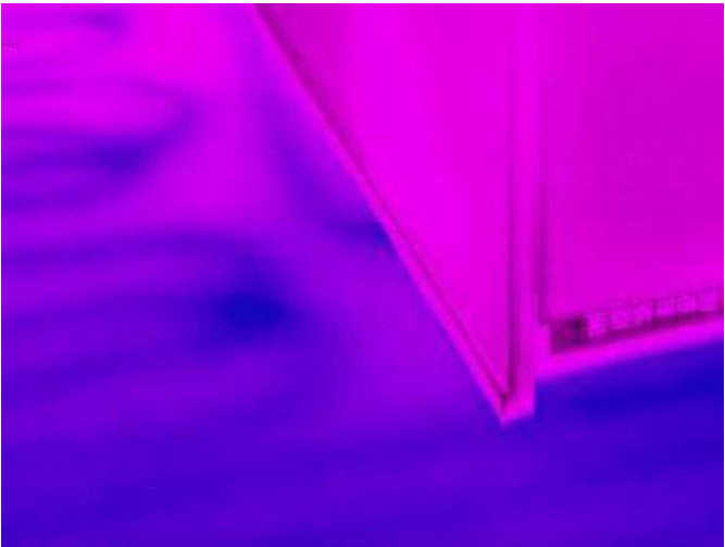
Avvik 35: varmekabel er ikke installert i henhold til fabrikantens anvisning, ikke fagmessig utført. Kabel ligger innunder vegg. I tillegg krysser den sin egen bane, ref minimum C-C på 5 cm.
