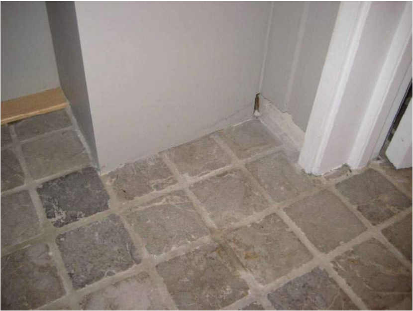
Avvik 26: Digitalt bilde av termogram over.
