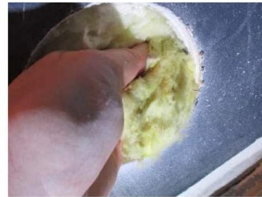
Foto 10. Yttervegg til høyre for vindu. Våt isolasjon i hull o vegg i nedkant.
