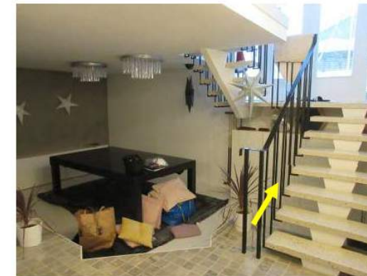
Foto 29. Biljardrom/«kjellerstue» i 1. etg. Lukt av kjeller/muggsopp ble registrert. Inspeksjonshull ble laget i yttervegg under trapp, pil.
