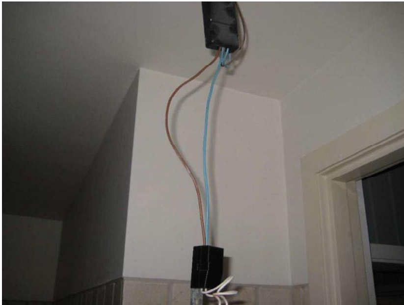
Avvik 27: PN ikke godkjent til dette formålet. (denne bruken)
