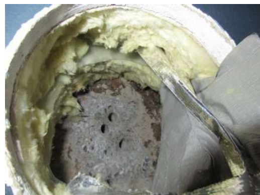
Foto 8. Kondensering registrert på tapen som midlertidig forseglar dampspærren. Hull i øvre del av ytterhjørnet delvis utført (tidligere eier).
