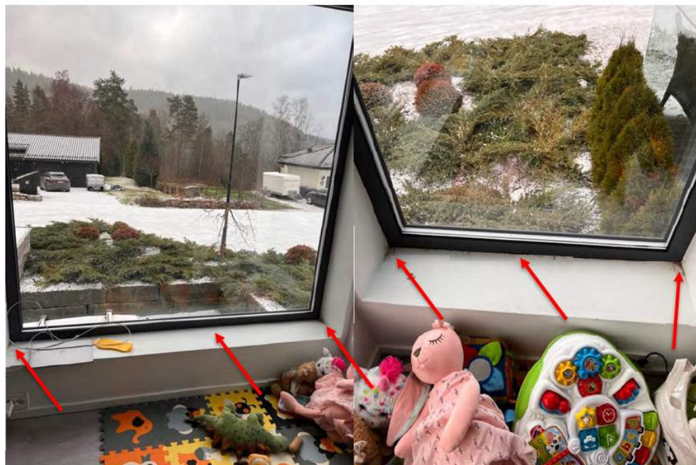
Piler på bildene over viser sopp i vinduskarmen. Disse vinduene er i stuen til utleieleiligheten. Slike vinduer er også montert i hovedboligen. Vinduene har for smal karm (dårlig isolering) og er ikke tilstrekkelig isolert og tett rundt.
