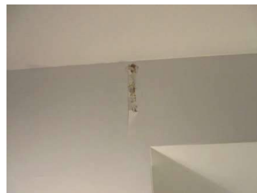
Foto 41. Kjøkken/spisestue. Kontroll i øvre del av yttervegg hvor det ble registrert sprekke viste ikke fuktutslag eller synlige tegn til muggsoppvekst.
