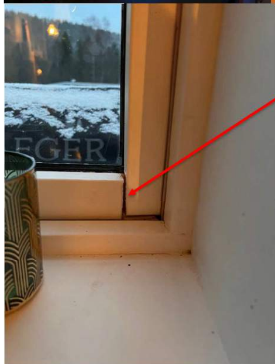
Bilder over viser et vindu på kjøkkenet som har fuktskadet ramme. Glassruten faller ut av rammen dersom vinduet åpnes.
