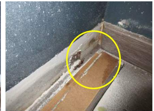
Foto 11. Ytterhjørne. Muggsoppvekst på gipsplate bak gulvlist (ring). Dette er under hull i øvre del av vegg (tidligere eier). Fukt-/ muggsopp registrert bak løsnet gulvlist.
