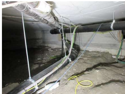
Foto 51. Krypekjeller. Rørføringer og kabler.
