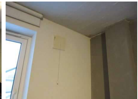
Foto 24. Lufteluke i yttervegg.
