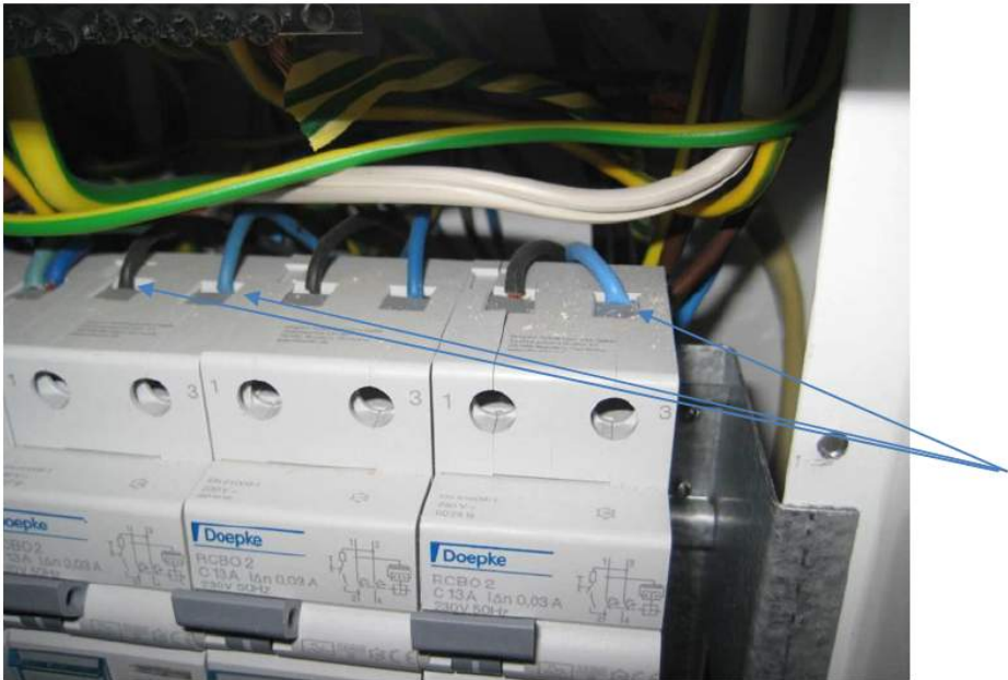
Avvik 17: Lederisolasjon ligger under tilkoblingsklemme. Økt fare for kontaktsvikt.
