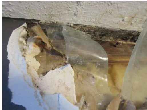
Foto 20. Nærbilde av lekkasjepunkt i overgang støpt himling og yttervegg. Synlig muggvekst på gips og misfarging på troppsvill. Prøve ble tatt med.
