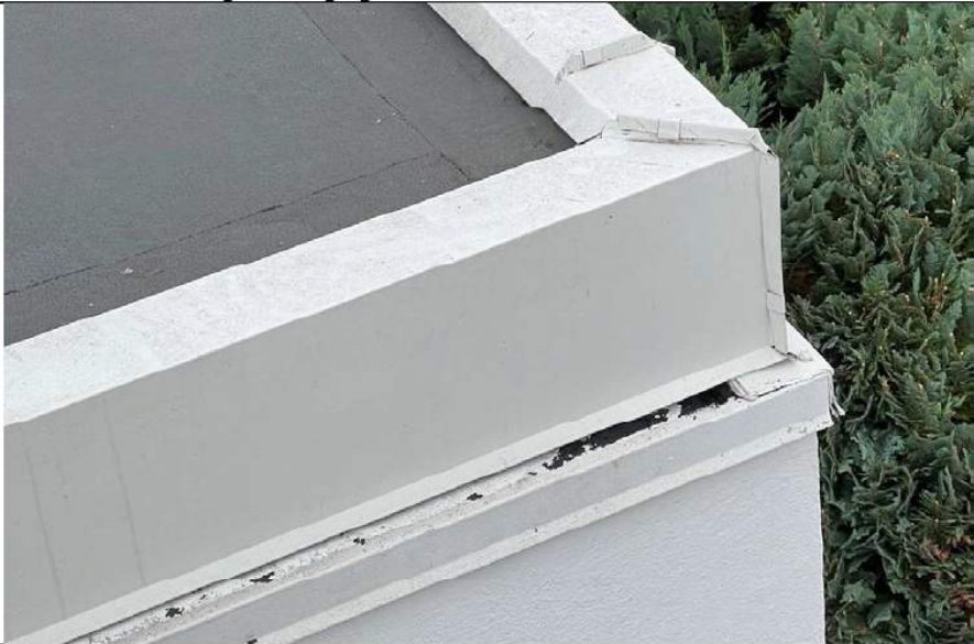
10. De gamle beslagene i underkant av nyere beslag mangler fall, og har ikke tette skjøter.
