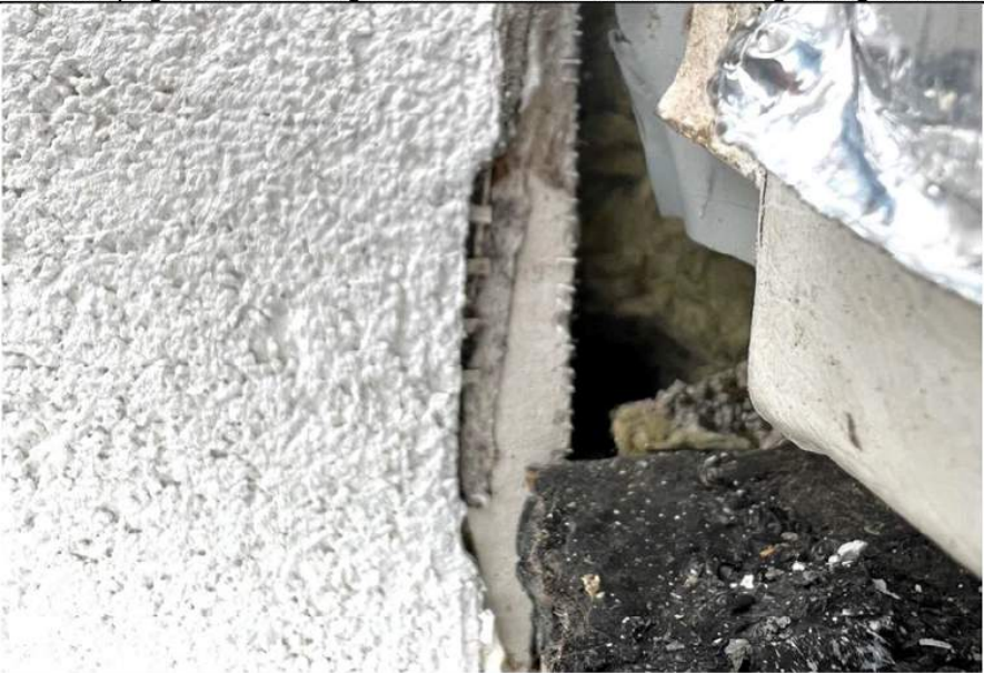
12. Bildet viser manglende totrinns tetting bak beslag mot vest. Her er det åpent rett inn i isolasjonen. Det er ikke avdekket skader innvendig, men utførelsen er ikke fagmessig.
