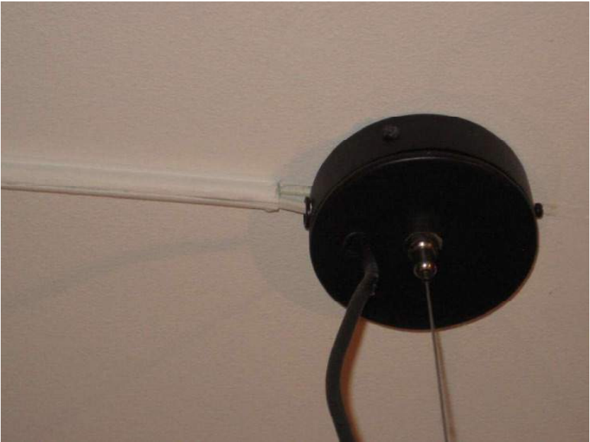
Avvik 52: PL er ikke godkjent til fast installasjon. Denne mangler også jordleder.
