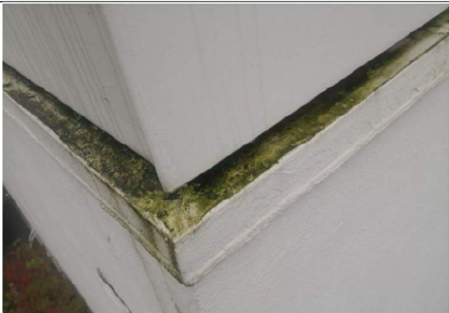
14. Bildet viser hjørne over treningsrom mot vest. Her mangler fall på beslag.
