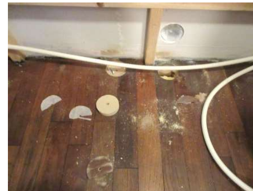
Foto 21. Hullboring i nedkant av yttervegg og i tregulv ble utført for kontroll.
