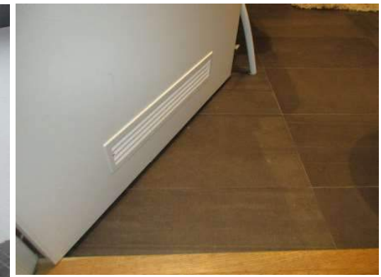
Foto 6. Lufterister nylig montert i dørene for bedret luftsirkulasjon mellom rommene.
