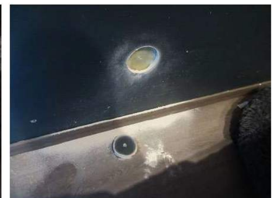
Foto 13. Hullboring i langvegg under terrengnivå. Gipsplate, dampsperre og isolasjon mot støpt vegg. Dersom veggen ligger vesentlig under terrengnivå så skal det ikke være innlagt dampsperre.
