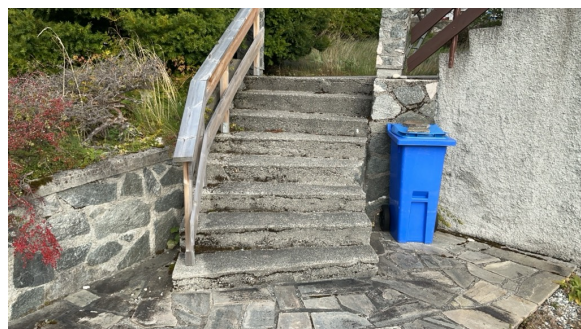
Mangler rekkvert
