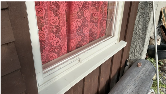
Eldre vinder i kjelleren
