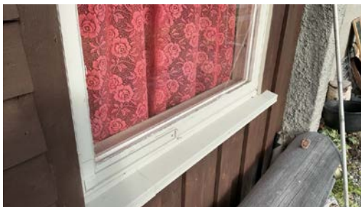
Eldre vinder i kjelleren
