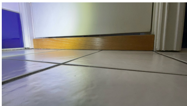
Membran kan ikke verifiseres
