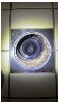
Sluk- membran kan ikke verifiseres
