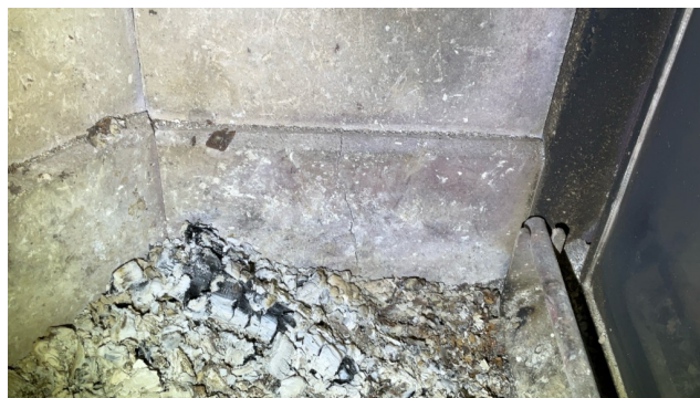
Sprekk ildfast stein peisovn kjeller
