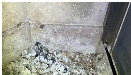
Sprekk ildfast stein peisovn kjeller
