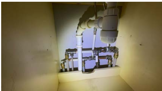
Synlig membran på vegg i innredning
