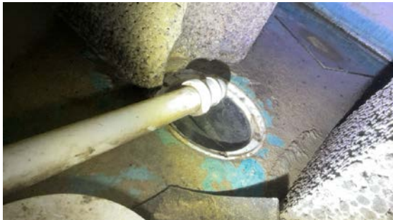
Sluk under kar "flommer" ved rask tapping av kar
