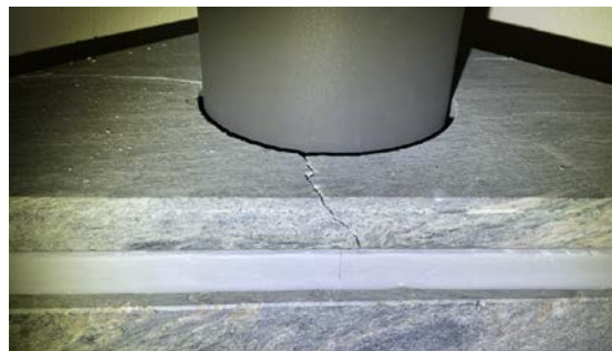
Sprekk toppplate peisovn kjeller
