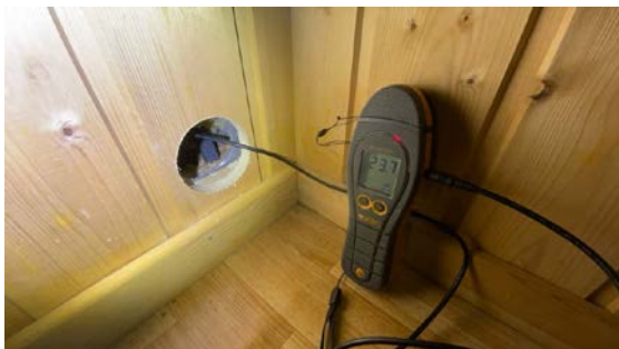
Hulltagning- 24 vekt% fukt og plastfolie i påforingskonstruksjon
