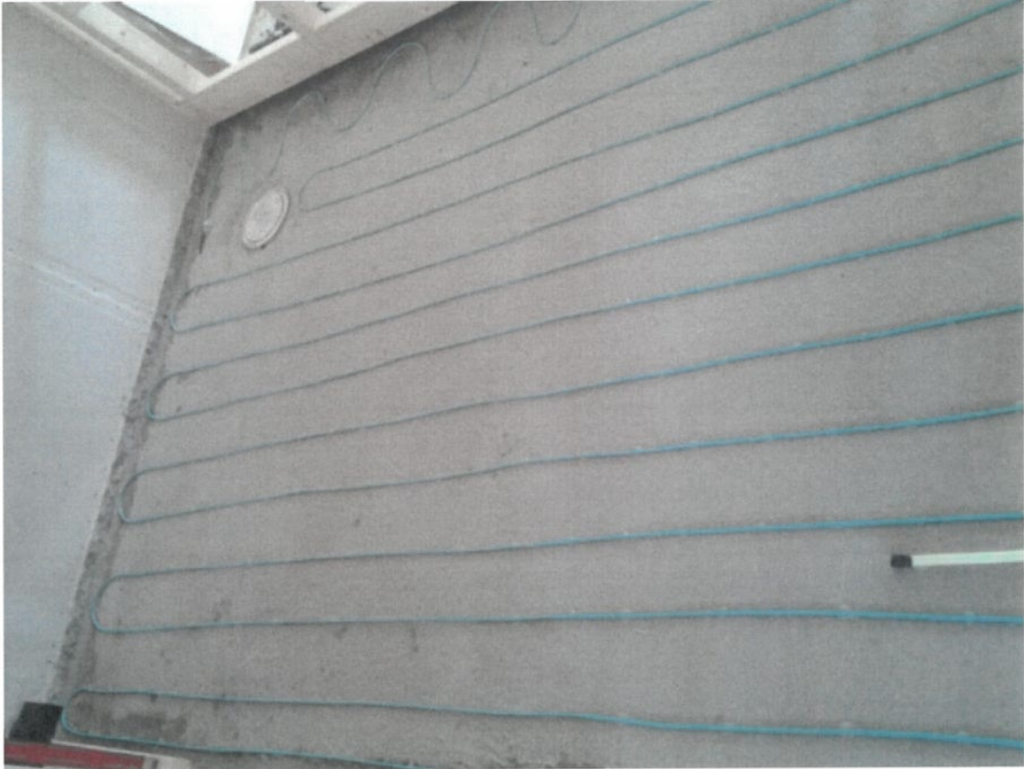
Skjema 'Varme ©Øglend Systems'. Filnavn: 20160819_112357.jpg.
