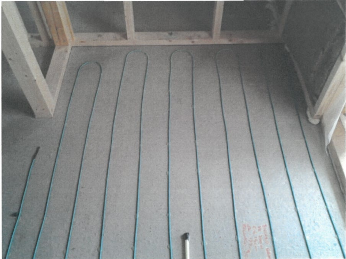
Skjema 'Varme ©Øglend Systems'. Filnavn: 20160819_110412.jpg.
