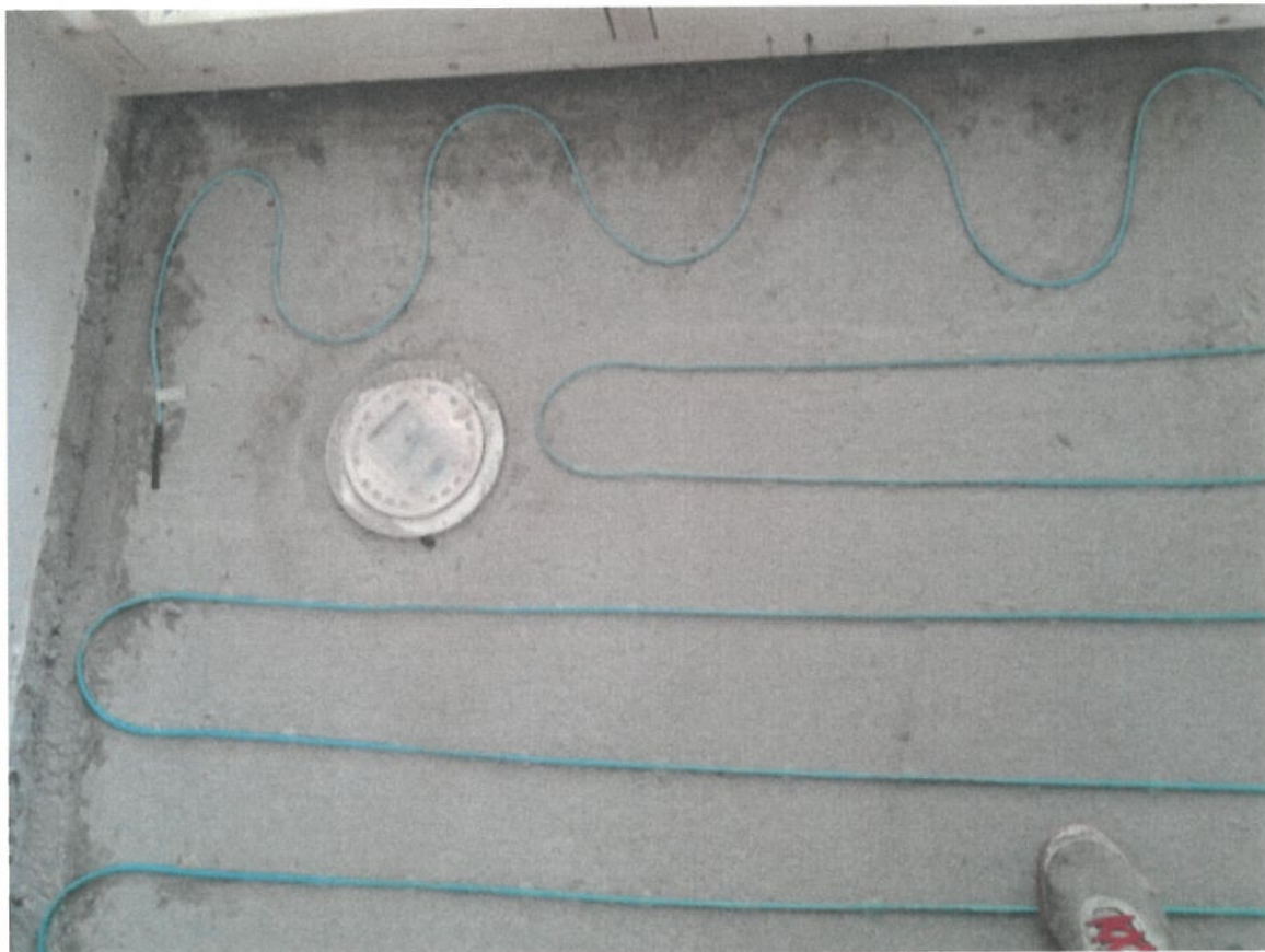
Skjema 'Varme ©Øglend Systems'. Filnavn: 20160819_112406.jpg.
