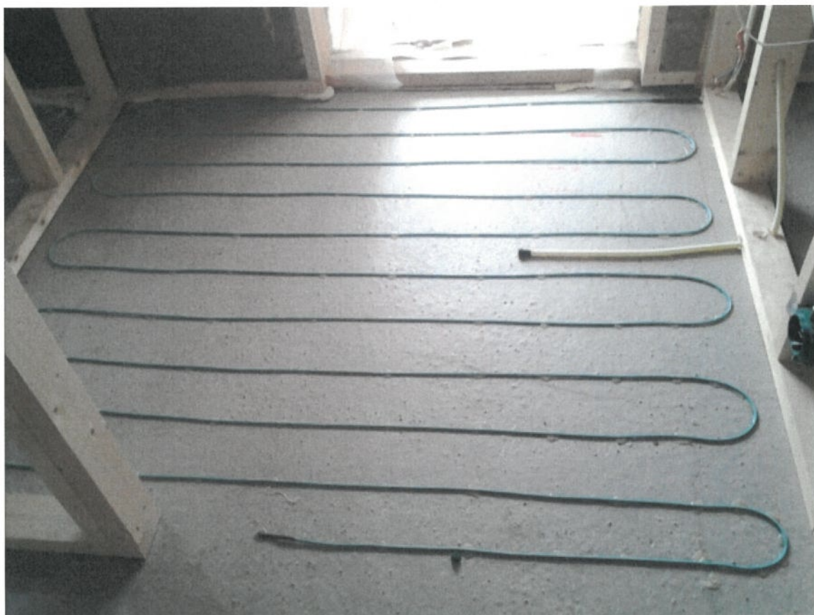
Skjema 'Varme ©Øglend Systems'. Filnavn: 20160819_110402.jpg.
