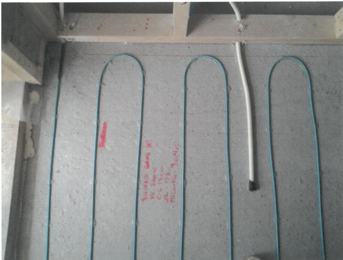
Skjema 'Varme ©Øglend Systems'. Filnavn: 20160819_110354.jpg.
