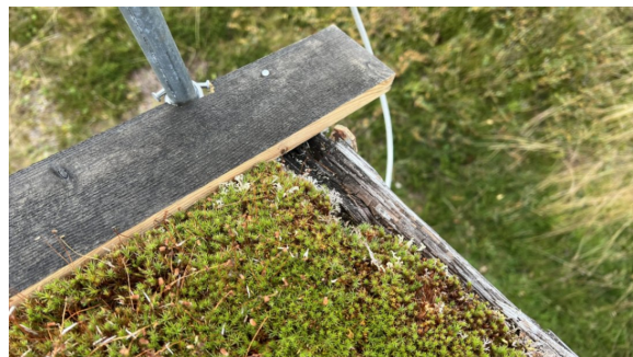
Råteskadet torvhaldstokk
