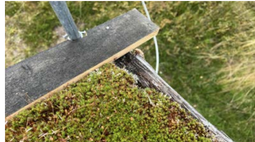
Råteskadet torvhaldstokk
