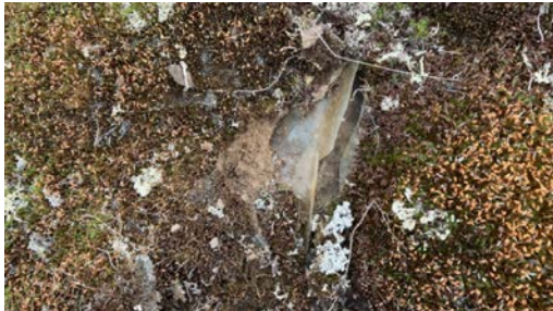
Skade i plastunderlaget
