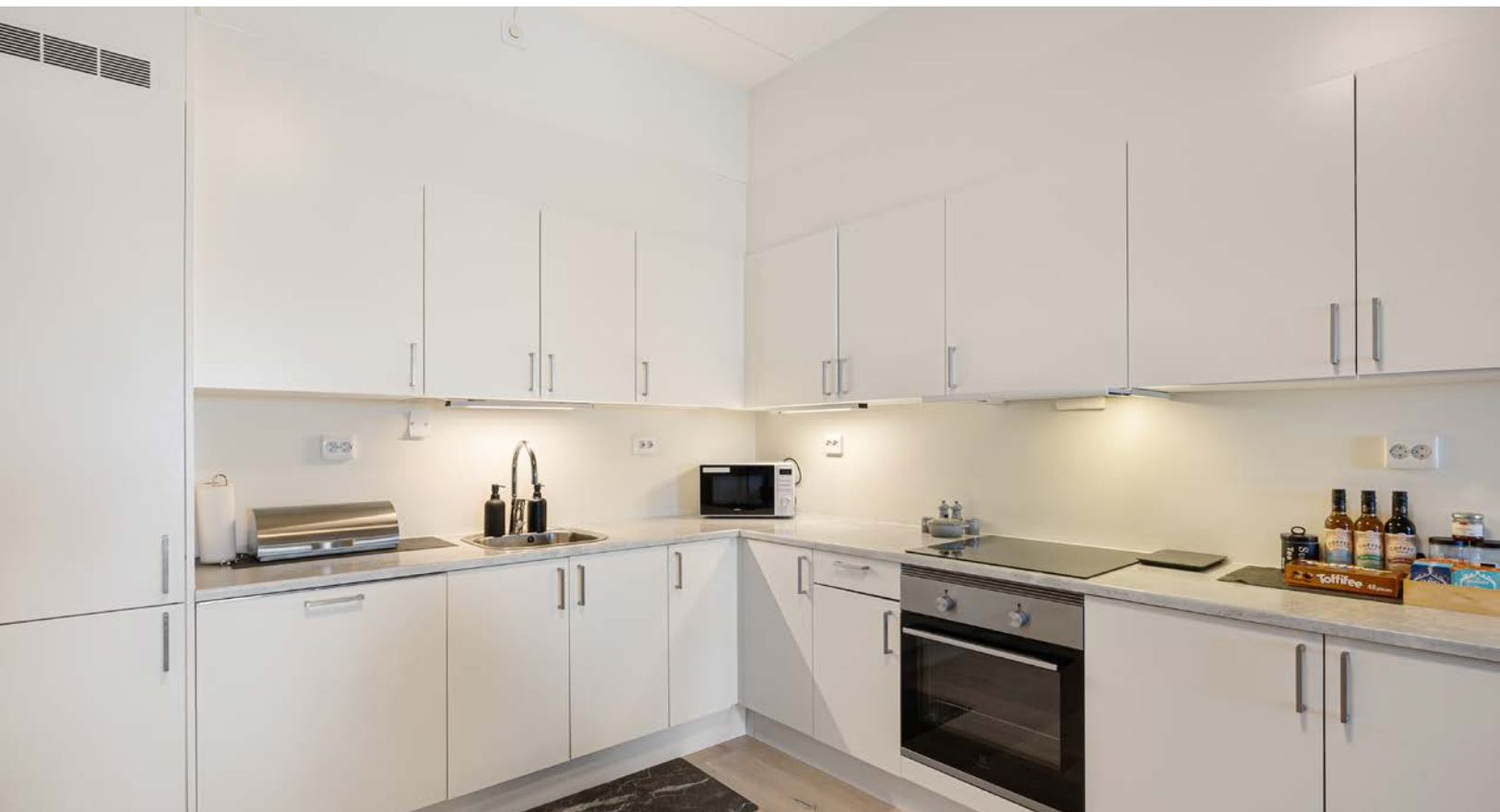
Innredningen er oppført og har hvite, glatte fronter og laminatbenkeplate med oppvaskkum av metall.
