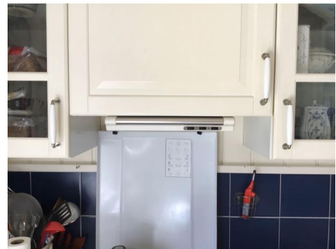
Montert avtrekk over komfyr.
