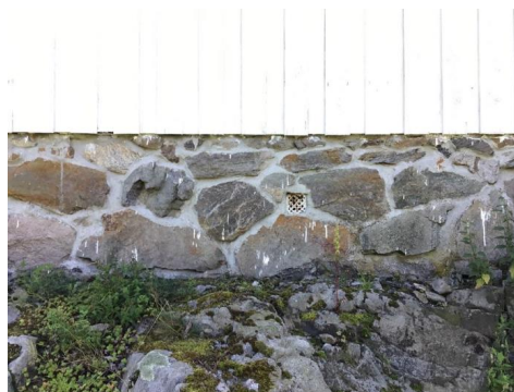
Del av grunnmur.
