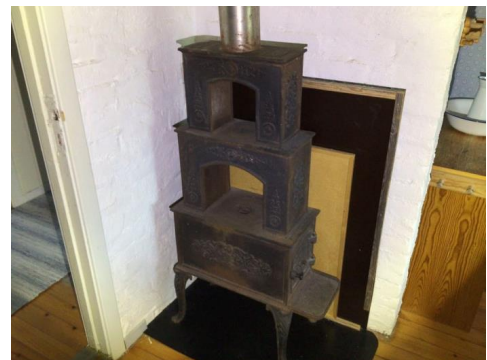
Montert ovn i 2 etasje.
