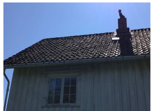
Del av taktekkning.
