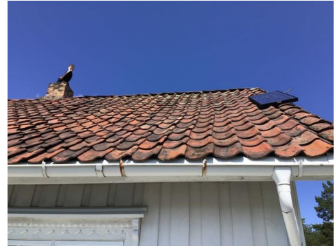
Del av taktekkning.
