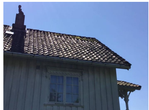
Del av taktekkning.
