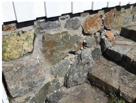
Del av grunnmur.
