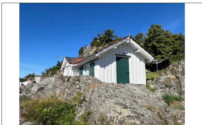
Bilde tatt av lille hytta på befaringdagen 12/8 2024.
