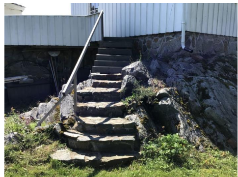
Trapp opp til terrasse.
