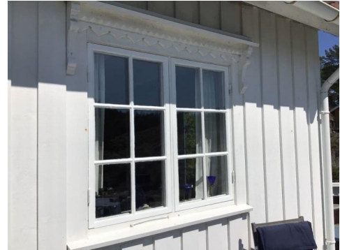
Eksempel på vindu i yttervegg.
