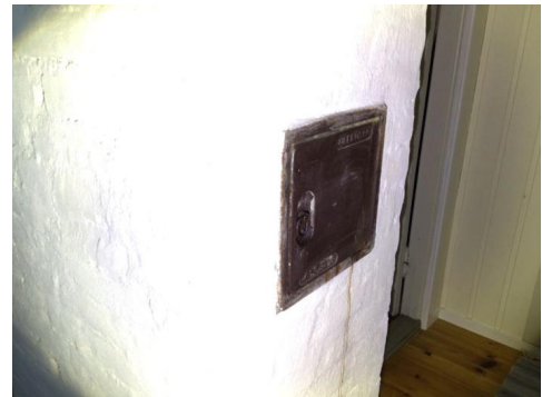
Feieluke i 2 etasje.
