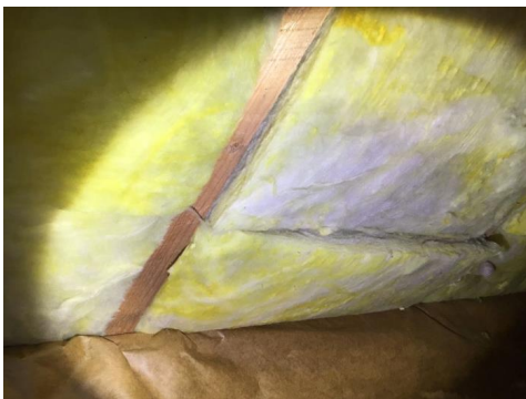
Konstruksjon sett fra loft.
