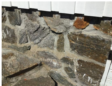
Del av grunnmur.
