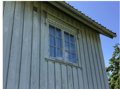
Eksempel på vindu i yttervegg.
