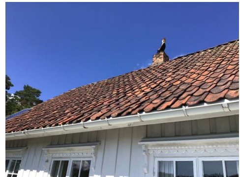
Del av taktekkning.
