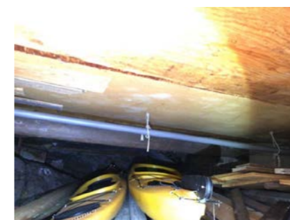
Del av etasjeskille sett fra undersiden.
