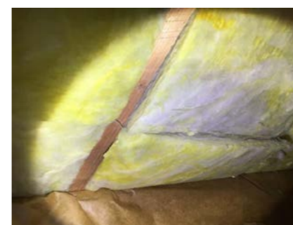
Konstruksjon sett fra loft.
