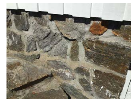
Del av grunnmur.
