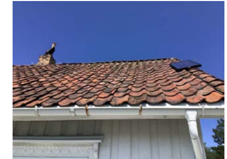
Del av taktekking.
