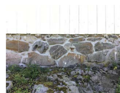
Del av grunnmur.
