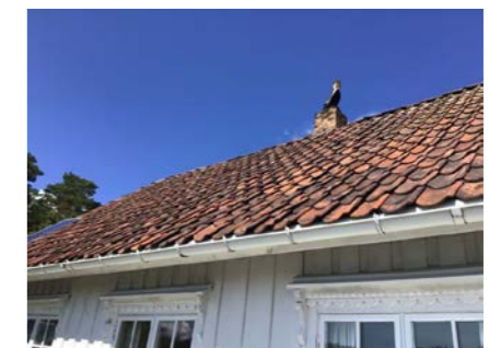
Del av taktekking.
