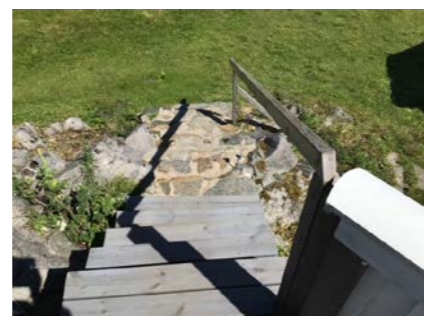
Trapp ned fra terrasse.
