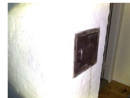
Feiluke i 2 etasje.
