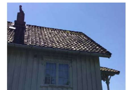
Del av taktekking.
