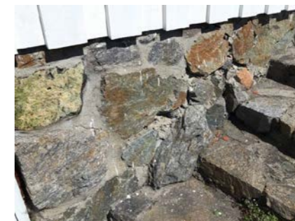
Del av grunnmur.
