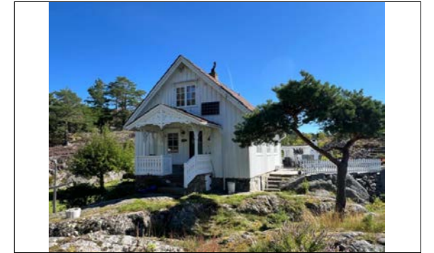
Bilde tatt av hovedhytte på befaringdagen 12/8 2024.
