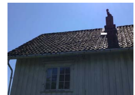
Del av taktekking.
