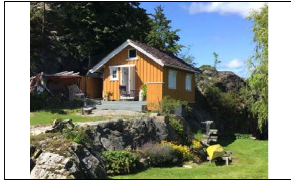
Uthus på eiendommen.
