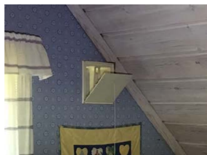
Eksempel på montert ventil i vegg.
