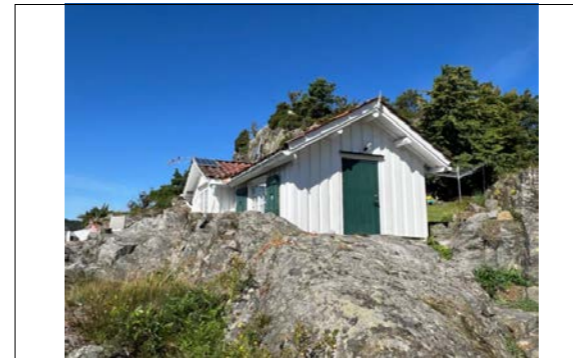
Bilde tatt av lille hytta på befaringdagen 12/8 2024.
