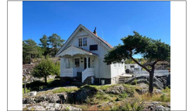
Bilde tatt av hovedhytte på befaringdagen 12/8 2024.
