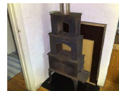
Montert ovn i 2 etasje.
