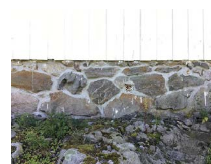
Del av grunnmur.
