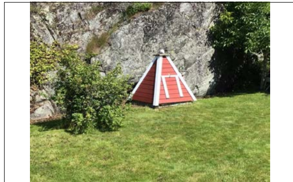
Brønnhus på eiendommen.
