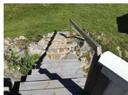
Trapp ned fra terrasse.
