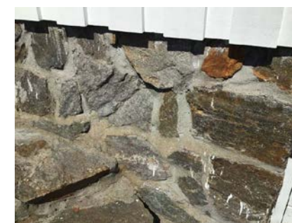
Del av grunnmur.
