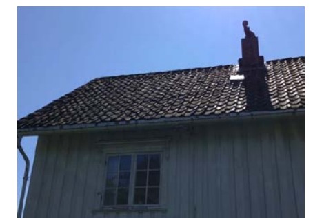
Del av taktekking.
