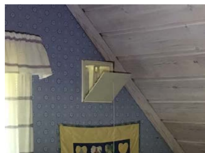
Eksempel på montert ventil i vegg.
