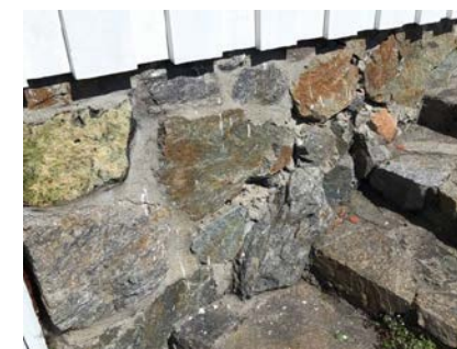
Del av grunnmur.
