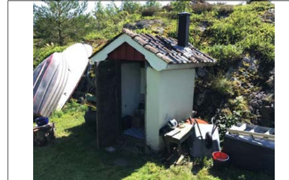
Lite bygg til gass og kjøleskap som går på gass.
