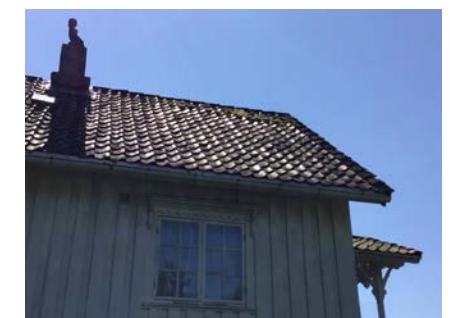
Del av taktekking.
