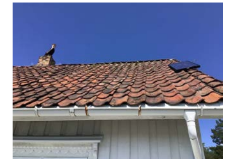
Del av taktekking.
