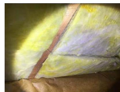
Konstruksjon sett fra loft.
