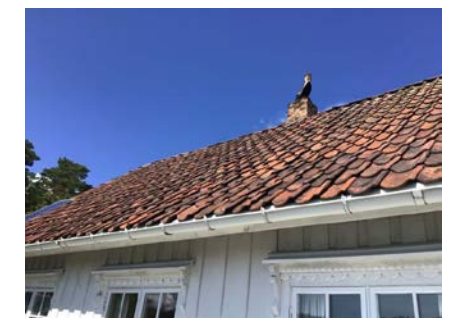
Del av taktekking.
