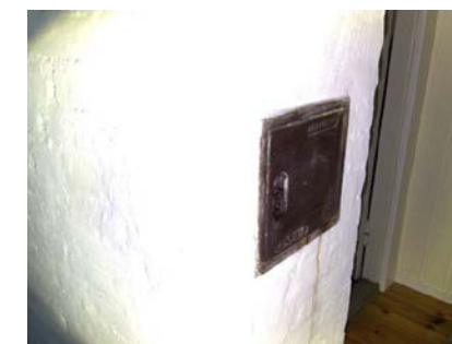
Feiluke i 2 etasje.
