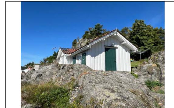
Bilde tatt av lille hytta på befaringdagen 12/8 2024.
