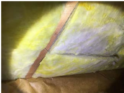
Konstruksjon sett fra loft.
