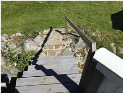
Trapp ned fra terrasse.
