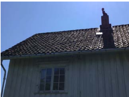
Del av taktekking.
