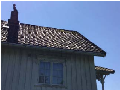
Del av taktekking.
