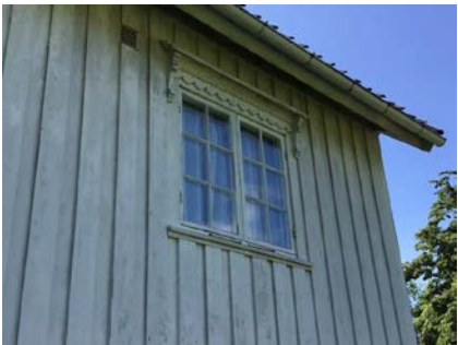
Eksempel på vindu i yttervegg.
