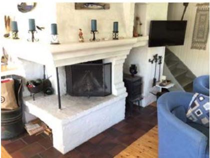
Murt peis og montert ovn i stue.
