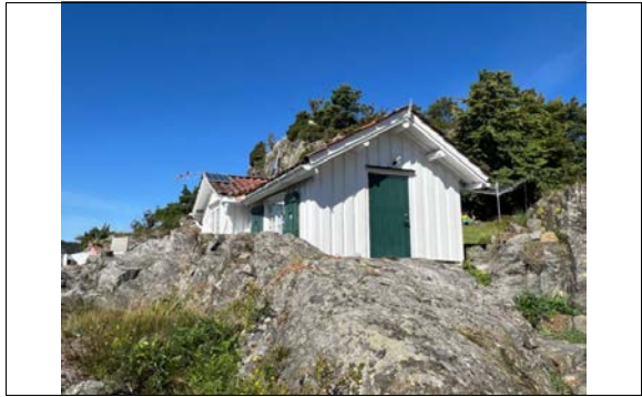
Bilde tatt av lille hytta på befaringsdagen 12/8 2024.
