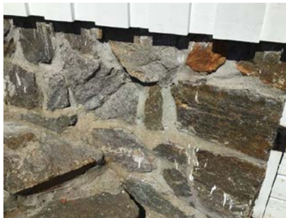
Del av grunnmur.
