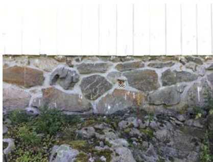
Del av grunnmur.
