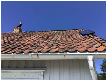
Del av taktekking.
