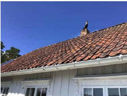
Del av taktekking.
