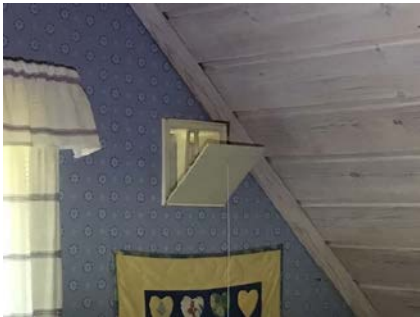
Eksempel på montert ventil i vegg.
