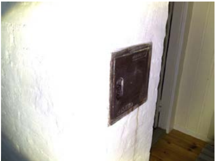
Feieluke i 2 etasje.
