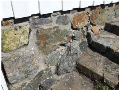
Del av grunnmur.
