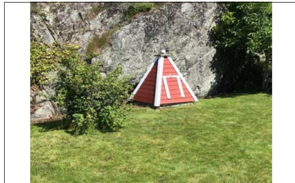
Brønnhus på eiendommen.
