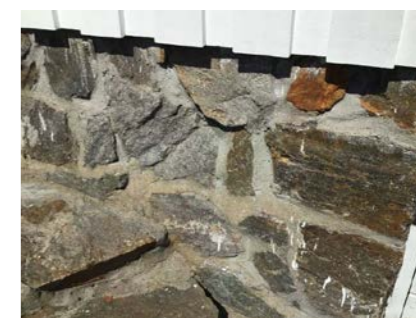
Del av grunnmur.
