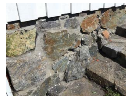
Del av grunnmur.
