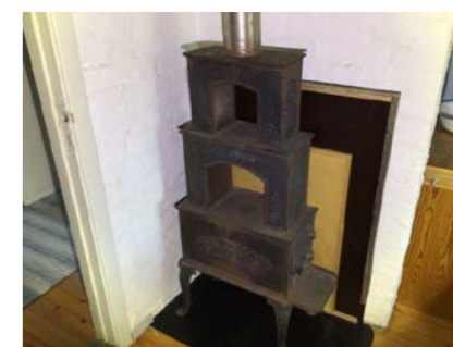
Montert ovn i 2 etasje.
