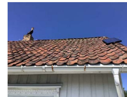
Del av taktekking.
