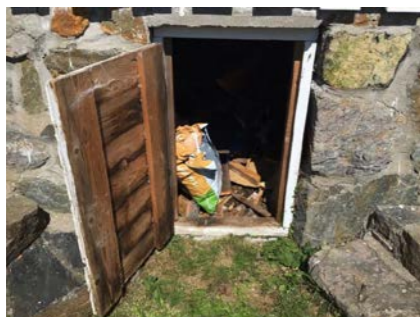
Løst inn til kryp kjeller.
