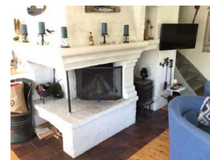
Murt peis og montert ovn i stue.
