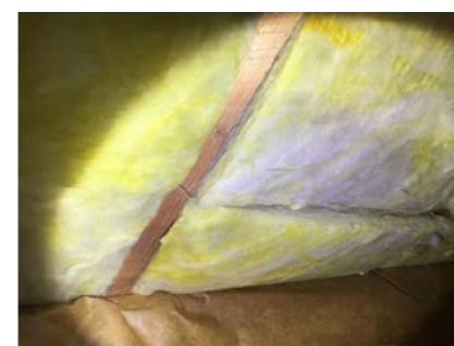
Konstruksjon sett fra loft.
