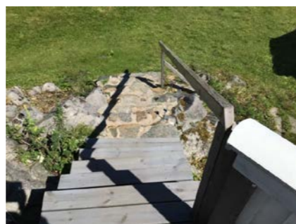
Trapp ned fra terrasse.
