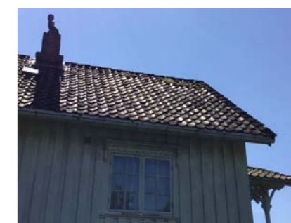
Del av taktekking.
