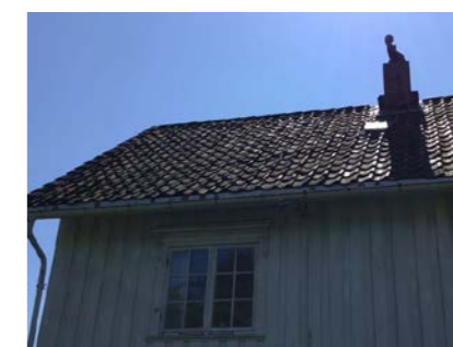
Del av taktekking.
