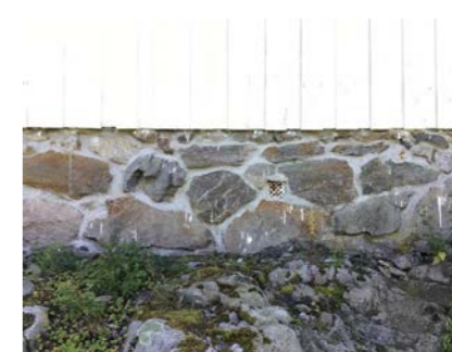
Del av grunnmur.
