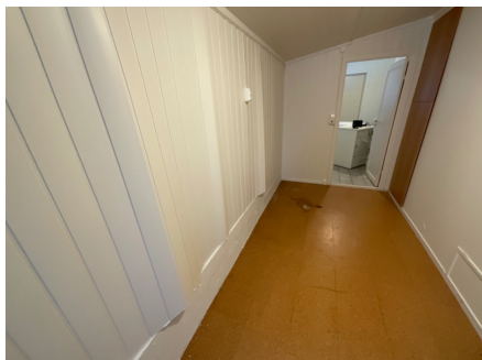
Plater som kuver ut i fra vegg.
