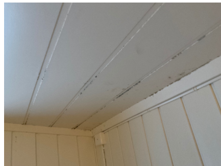
Svertesopp på overflater i tak.
