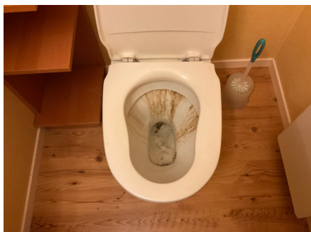
Toalett med lekkasje.
