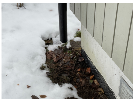
Taknedløp som mangler utkast
