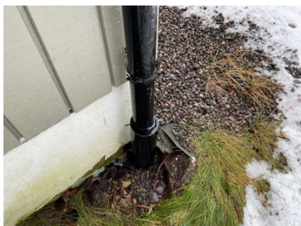
Tett drensrør i grunn
