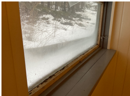
Vindu på vaskerom.
