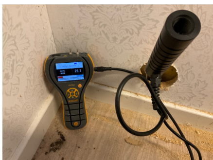
Fuktmåling i vegg under bakkenivå
