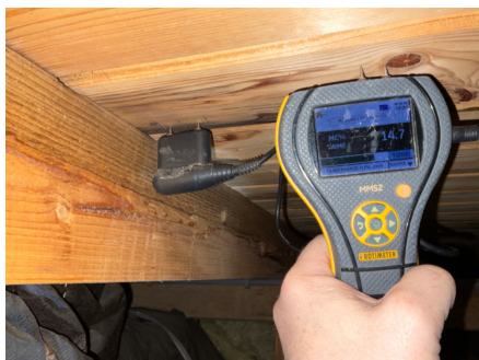
Fuktmåling på fuktskjolder i undertak
