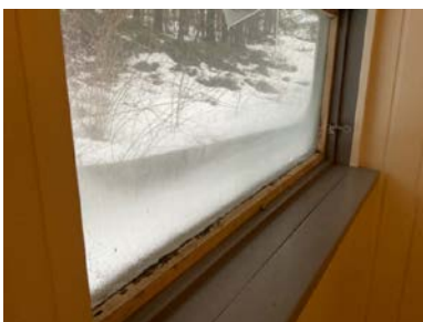
Vindu på vaskerom.
