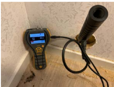
Fuktmåling i vegg under bakkenivå
