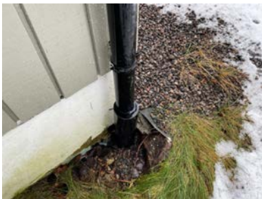
Tett drensrør i grunn
