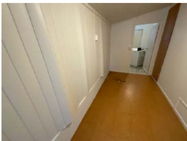
Plater som kuver ut i fra vegg.
