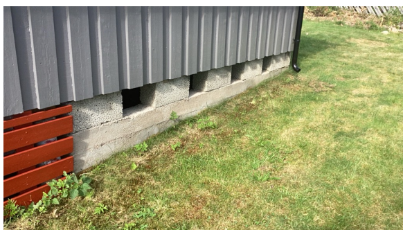
Eksempel på type fundamentering.
