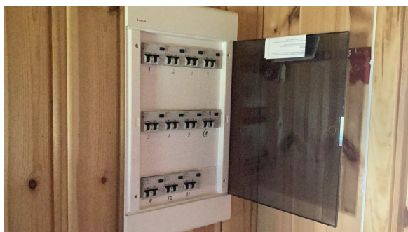
Innvendig sikringsskap
