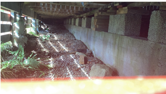
Eksempel på fundamentering.
