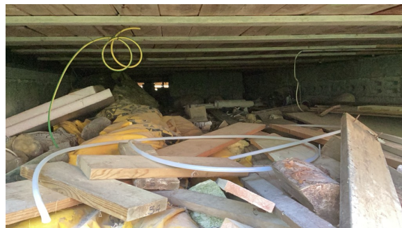
Oversikt fra undersiden av bjelkelag.
