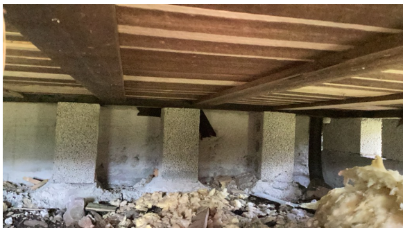
Oversikt fra undersiden av bjelkelag.
