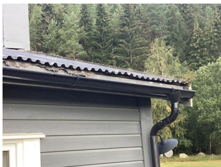
Det er stedvis ikke forkantbeslag.
