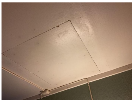
Det er skjært ut luke i himling.
