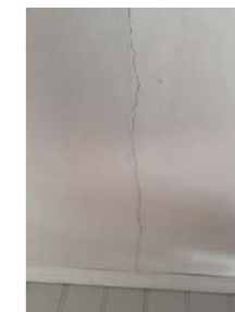
Eksempel på sprekk i himling.
