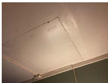
Det er skjært ut luke i himling.
