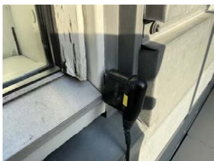
Fukt/råteskade på vindu i stue.
