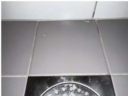
Riss/sprekk på flis.
