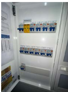
Sikringsskap med automatsikringer.
