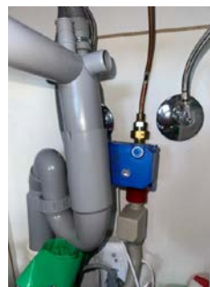
Rørapplegg i kjøkkenbenk med Waterguard
