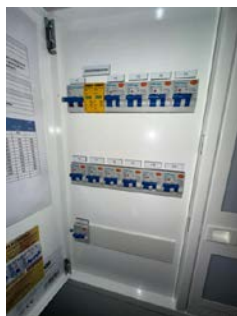
Sikringsskap med automatsikringer.
