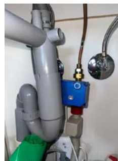
Rørapplegg i kjøkkenbenk med Waterguard
