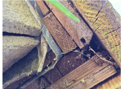
Oppunder utvendig kledning
