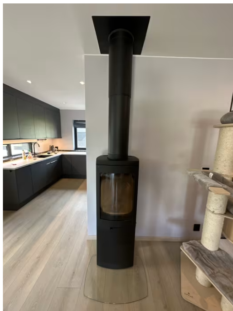
Viser ildsted montert i stue.
