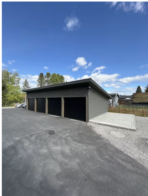
Viser felles garasjeanlegg.
