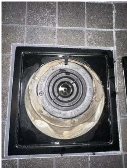
Viser sluk i dusjsonen.
