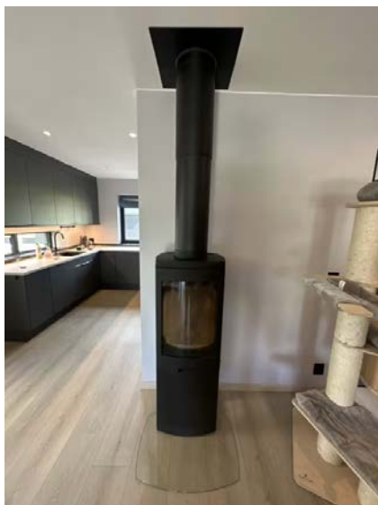
Viser ildsted montert i stue.
