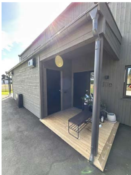
Viser bod med utvendig adkomst.
