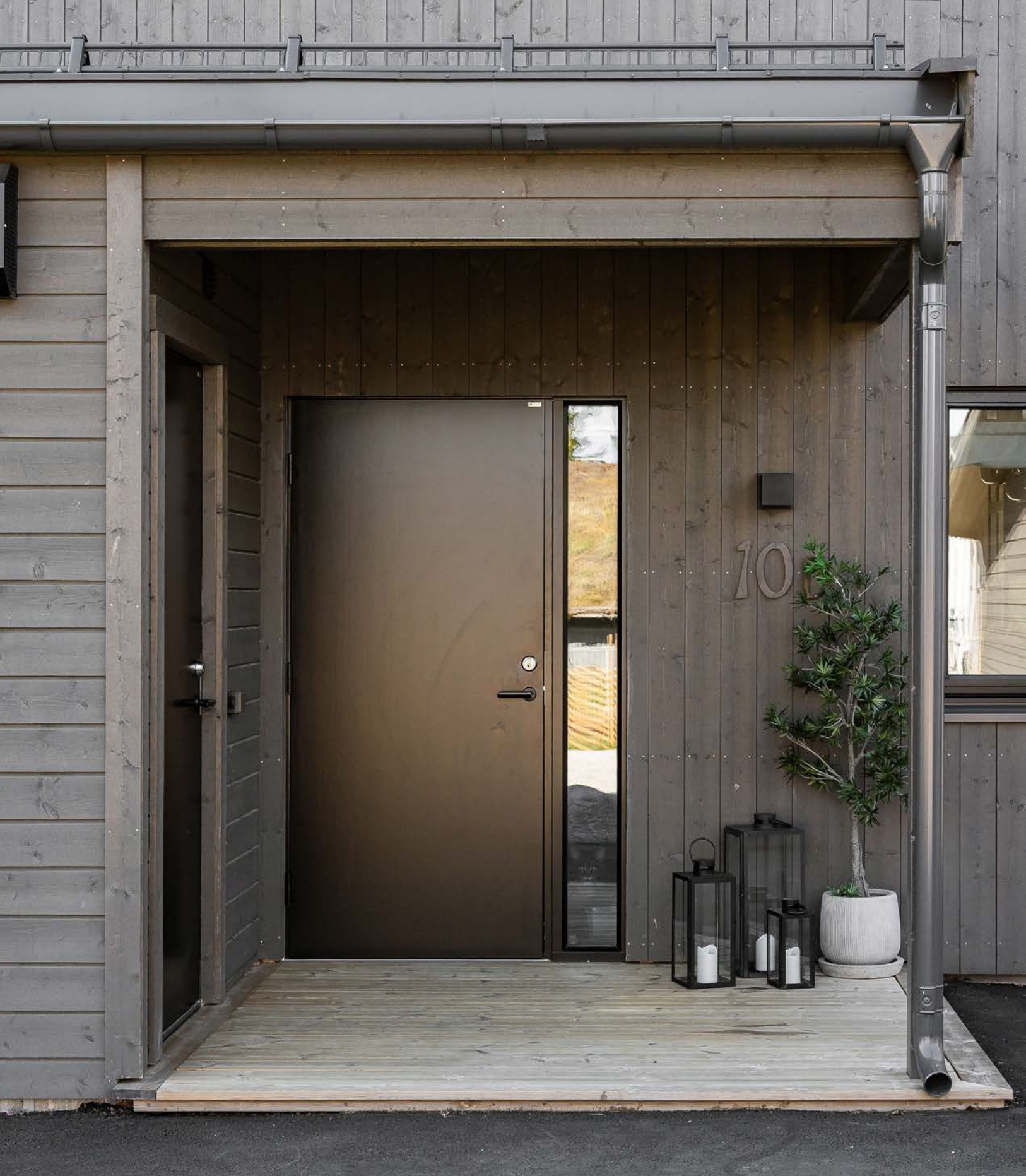
Inngangspartiet har utebelysning og stikkontakt på vegg.
