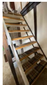
Trapp mellom leilighet i 1. etasje og kjeller
