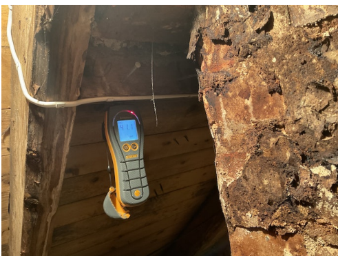
Fuktmåling rundt pipe.
